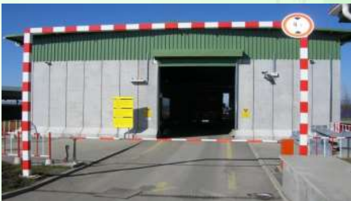
Hraničný priechod Vyšné Nemecké – skenovanie cestných vozidiel
