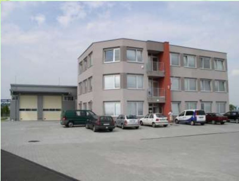
budova PCÚ Bratislava letisko
